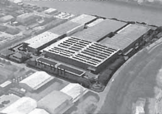
太陽光パネルを設置 半田ステンレス加工センター
