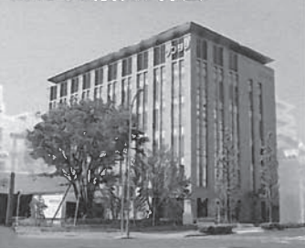
2013年2月竣工の本社ビル
